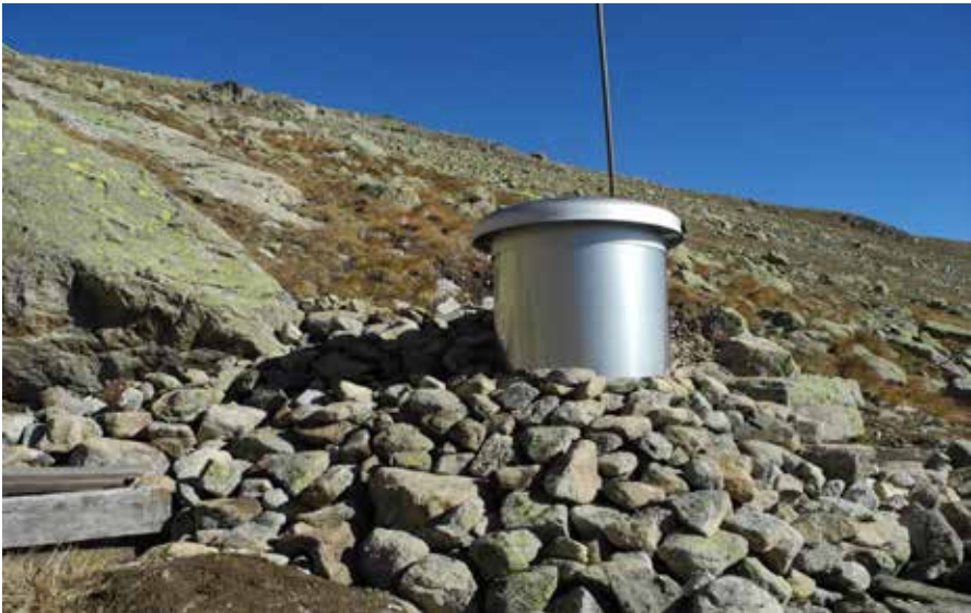
Quellwasserschutz - dank fleissigen Helfern wurde im Spätherbst die Quellfassung mit Steinen eingepackt
